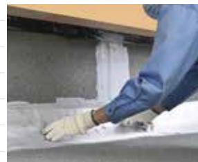
既存(L字型)端末金物上部と金物の谷部に増打ちし、谷部はヘラでならしてL字の段差をなだらかにしてください。
