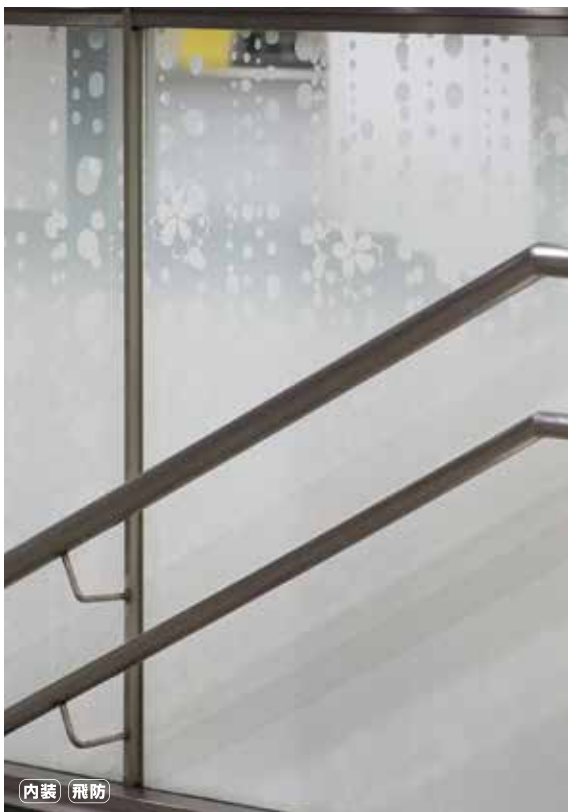
通行人の足元の目隠しとグラフィックをホワイトの濃度をコントロールすることにより実現しました。
