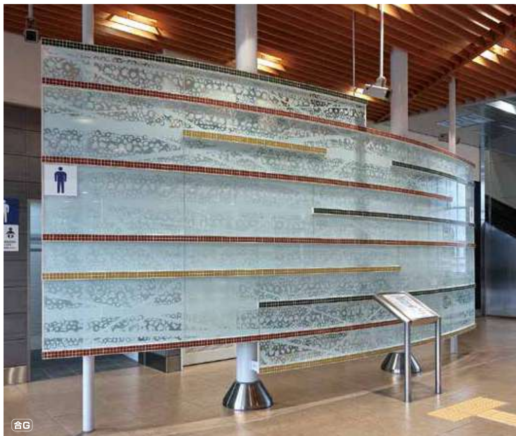
WC 前のガラススクリーンには、人の視線の位置にホワイトの濃度が高い部分が来るようにデザインを調整しました。
