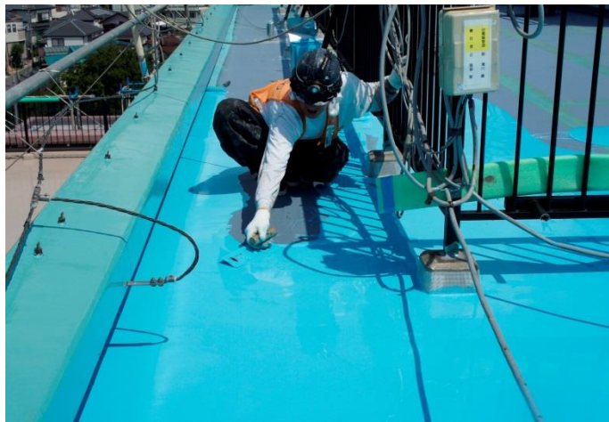
ウレタン塗膜防水によるマンションのルーフバルコニー改修工事事例
