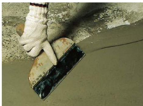
地べらで全面に塗布する。
