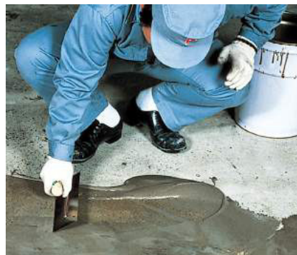
荷重床プライマー塗布後、左官ゴテを使用して下地にすこむように塗布
