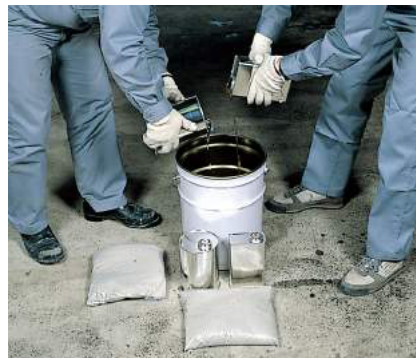
A液とB液を重量比で混合(必ず攪拌機を使用する)
