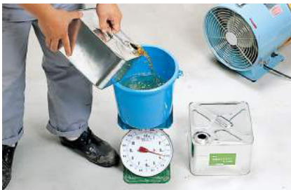
A液とB液を計量計を使用して調合(重量比)
