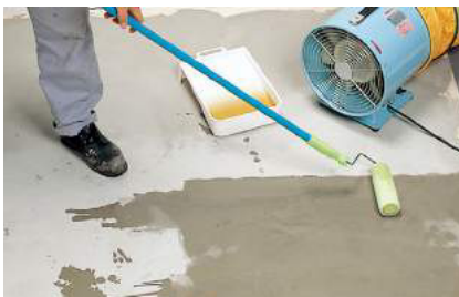
ローラーバケで塗布。塗布時は必ず換気ファン(防爆型)を使用
