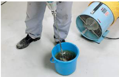
攪拌機でしっかり混合
