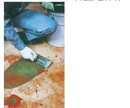
⑤荷重床プライマー硬化後、荷重床ハードナーを塗布
