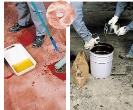
①荷重床プライマーを塗布 ②A液とB液を重量比で混合(必ず攪拌機を使用する)
