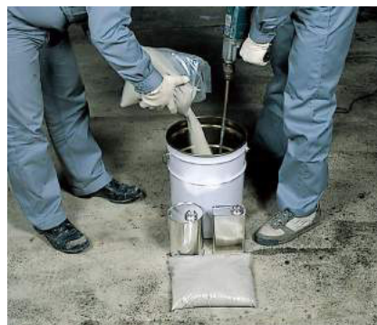
骨材を混合(必ず攪拌機を使用する)
