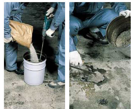
③骨材を混合(必ず攪拌機を使用する) ④左官ゴテで押しつけるように塗布(下地のレベルより低目に塗布する)
